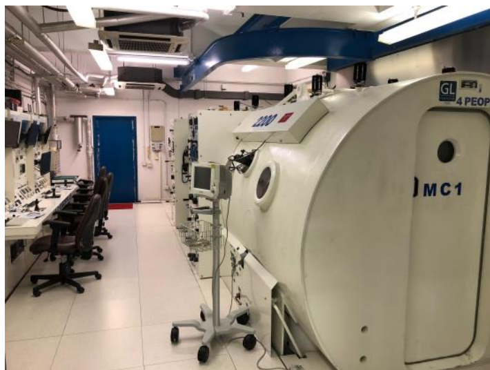
昂船洲高壓氧療法設施（外觀） （相片由消防處提供）
