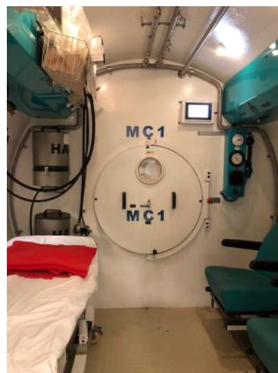
昂船洲高壓氧療法設施（內部） （相片由消防處提供）
